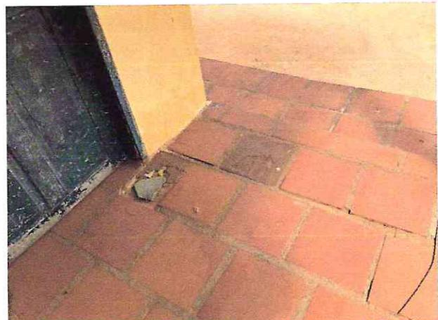
**Observações:** Piso com rachaduras, partes danificadas e soltas.
