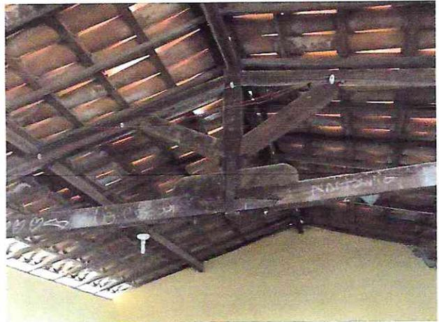
**Observações:** Estrutura da tesoura comprometida, com fissuras.
