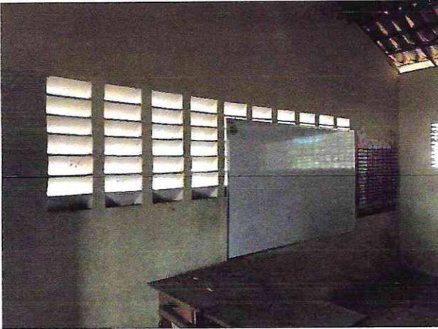
**Observações:** Alvenaria com mofo e infiltração.
