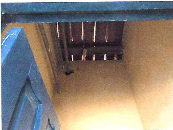
**Observações:** Tubulações aparentes com rachaduras em alvenaria.
