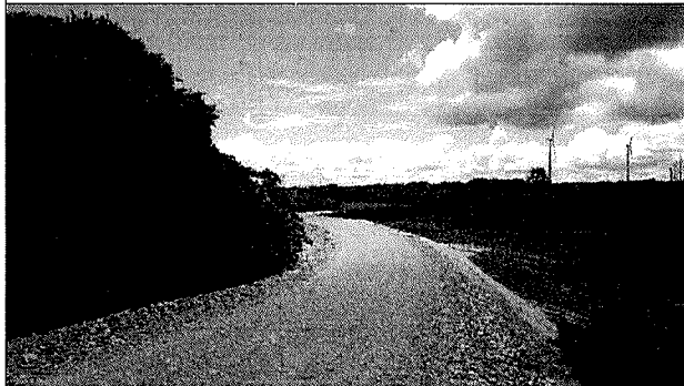
Visão Geral da via - Estaca 0+550,00
