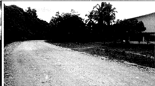
Visão Geral da via - Estaca 0+740,00
