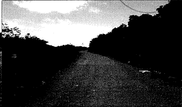
Visão Geral da via – Estaca 0+280,00
