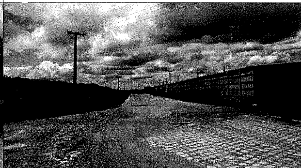
Final do Trecho – Estaca 2+488,00
