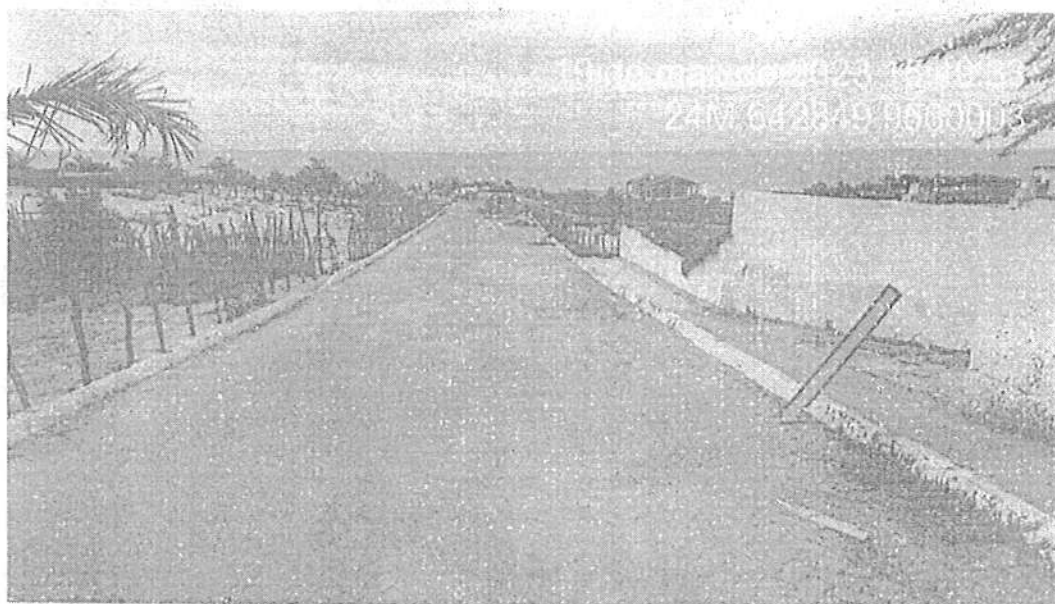
Foto 4(trecho5) – Melhoria executada pela construtora para evitar erosões laterais. Construção do passeio e ancoragem do meio fio.
