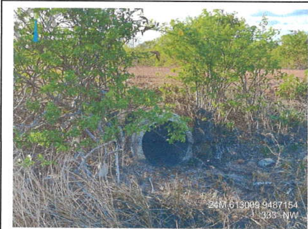
Visão de manilha existente da estrada
