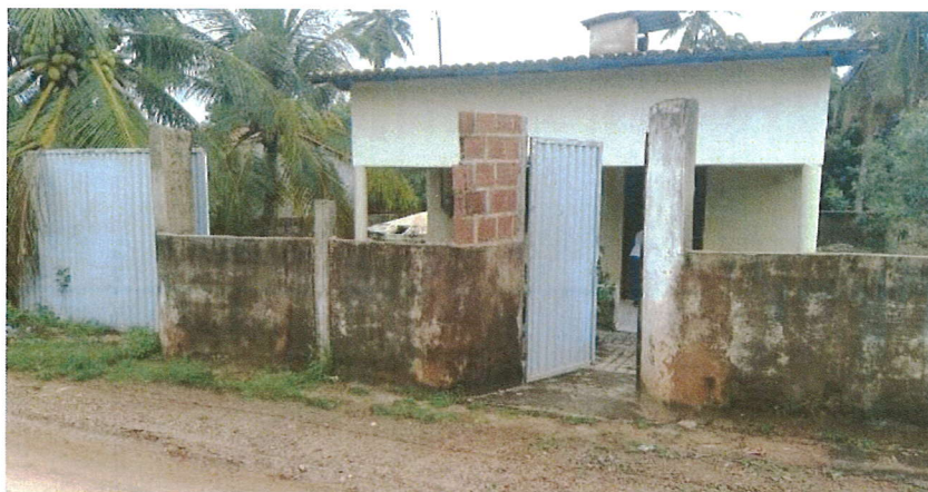
Fotografia 01 – Fachada do Imóvel.
