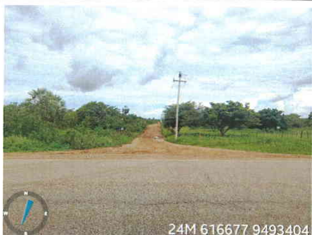
Local da interseção a ser construída (Vista da BR)
