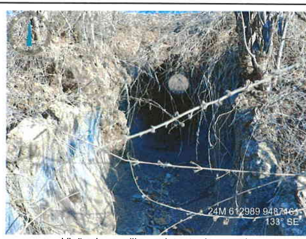
Visão de manilha existente da estrada
