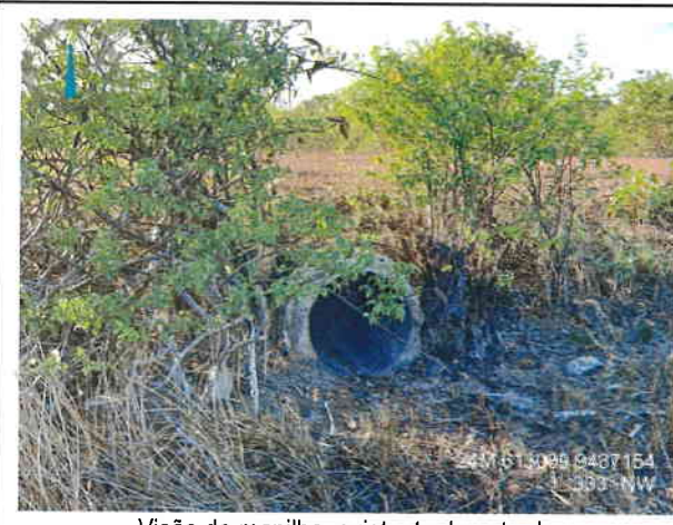
Visão de manilha existente da estrada
