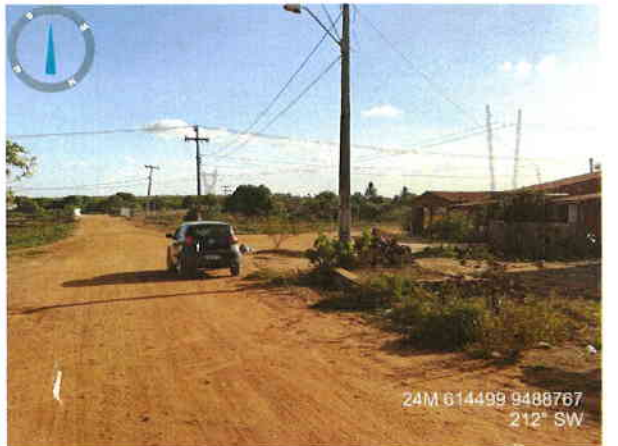
Visão geral da estrada próximo a ponte do canal
