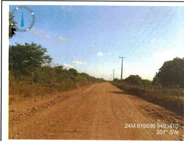
Visão geral da estrada
