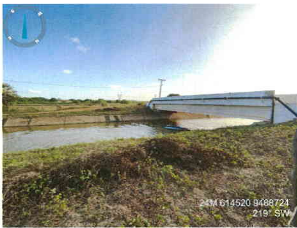
Visão da ponte da travessia do canal
