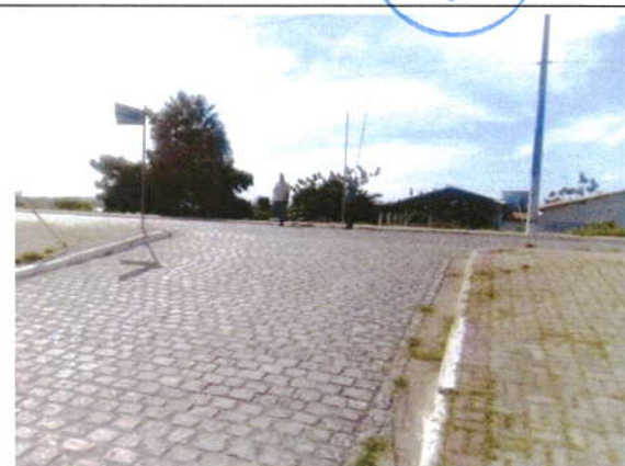
Foto 02 – Estrada do Dique, Vila Isaura.
