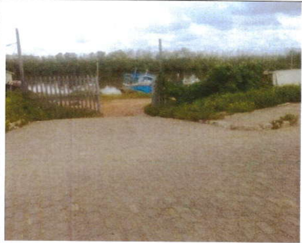
Foto 10 – Trecho onde será implantado o sistema de drenagem da Vila Isaura - Jusante.
