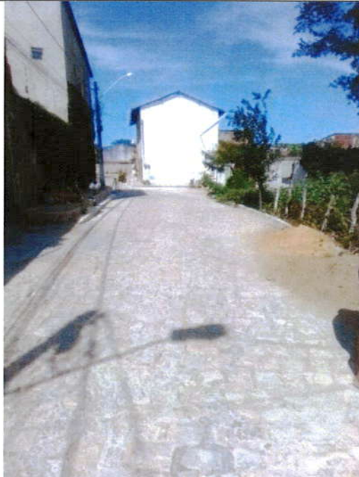
Foto 07 – Trecho onde será implantado o sistema de drenagem da Vila Isaura.
