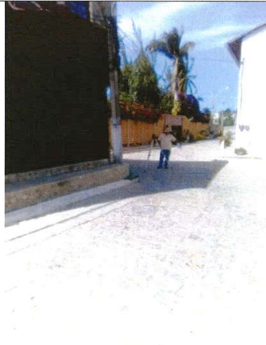
Foto 08 – Trecho onde será implantado o sistema de drenagem da Vila Isaura.
