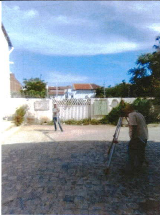
Foto 05 – Trecho onde será implantado o sistema de drenagem da Vila Isaura.
