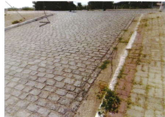
Foto 04 – Estrada do Dique, Vila Isaura.
