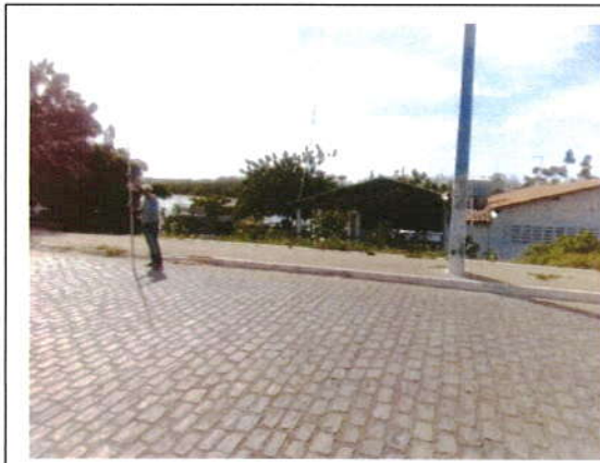
Foto 01 – Estrada do Dique, Vila Isaura.
