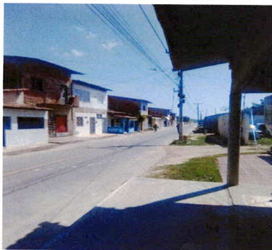
Foto 03: Pavimentação da Vila São Rafael
