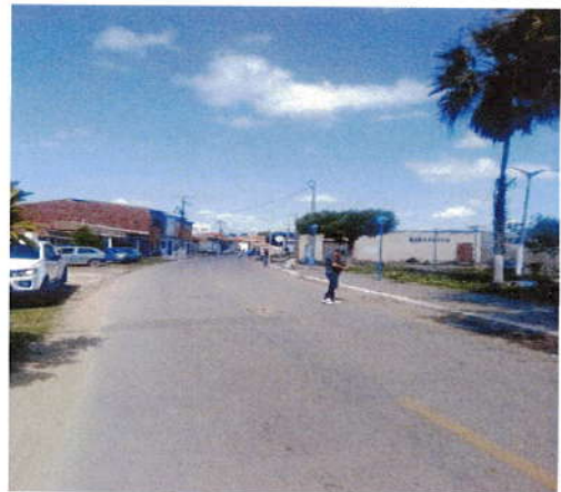
Foto 02: Pavimentação da Vila São Rafael
