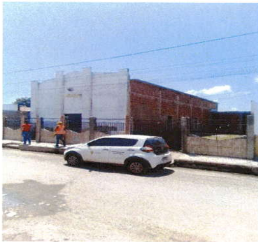
Foto 07: Pavimentação da Vila São Rafael
