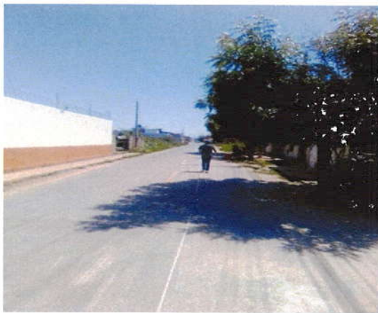
Foto 05: Pavimentação da Vila São Rafael
