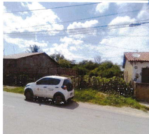
Foto 06: Pavimentação da Vila São Rafael
