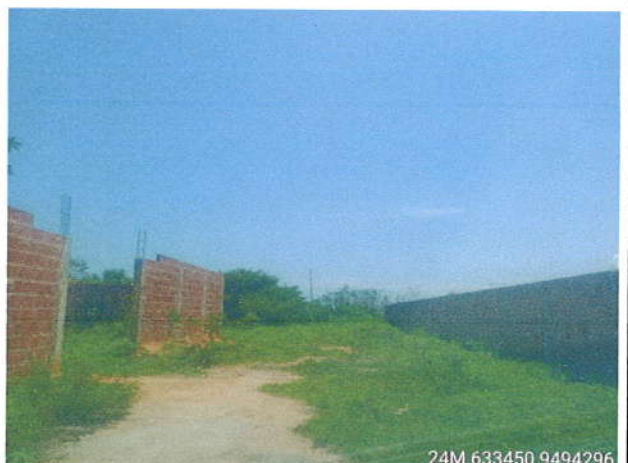
Vista Geral do Final da Rua SDO 01
