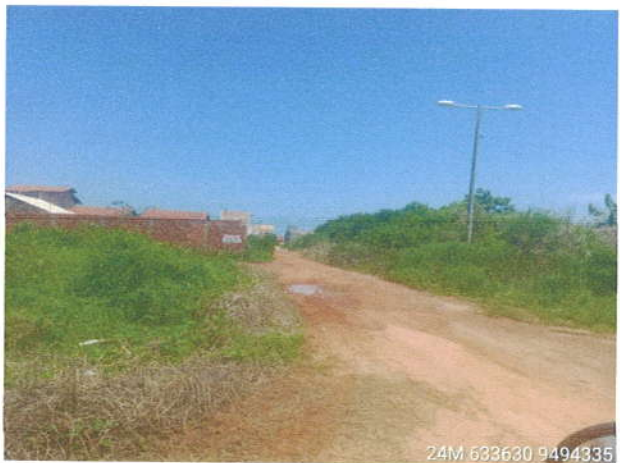
Vista Geral do Início da Rua SDO 02
