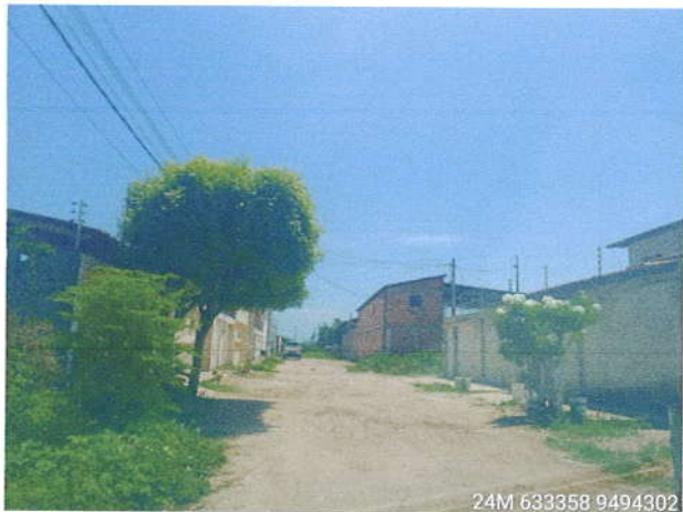
Vista Geral do Início da Rua SDO 01
