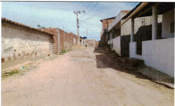
Foto 32 – Rua SDO 03 – Etapa II – Canoa Quebrada.
