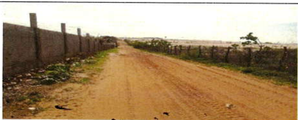
Foto 29 – Rua SDO 02 – Etapa II – Canoa Quebrada.
