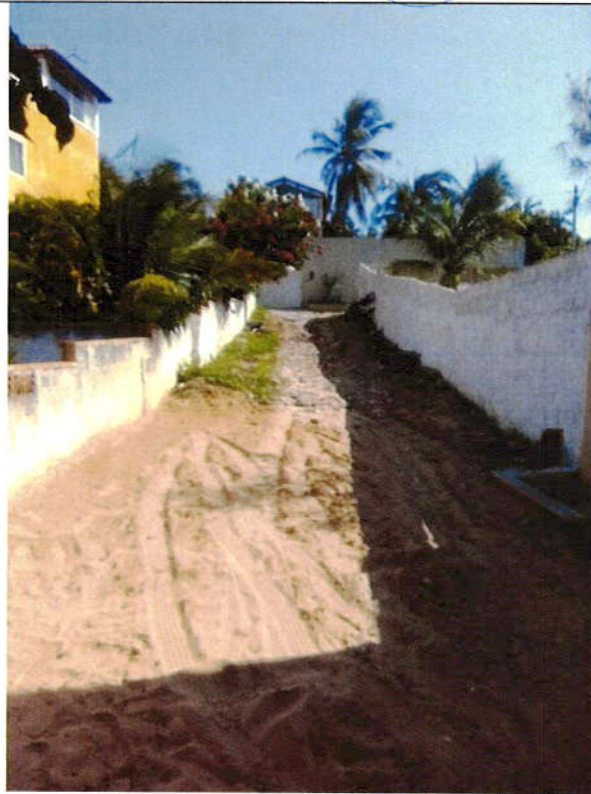
Foto 33 – Rua SDO 04 – Etapa II – Canoa Quebrada.
