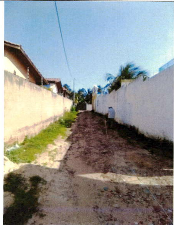
Foto 36 – Rua SDO 05 – Etapa II – Canoa Quebrada.
