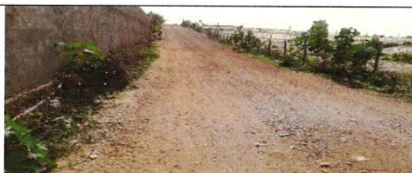
Foto 30 – Rua SDO 02 – Etapa II – Canoa Quebrada.
