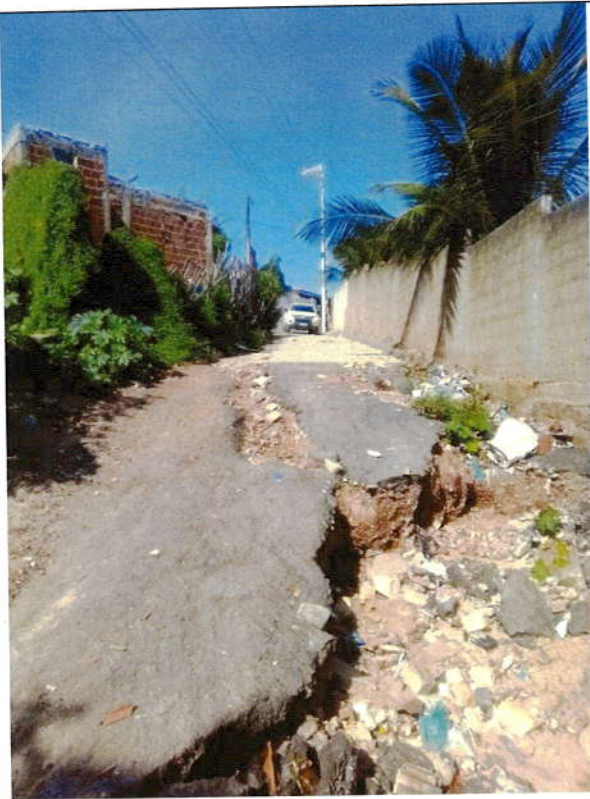
Foto 37 – Rua SDO 06 – Etapa II – Canoa Quebrada.
