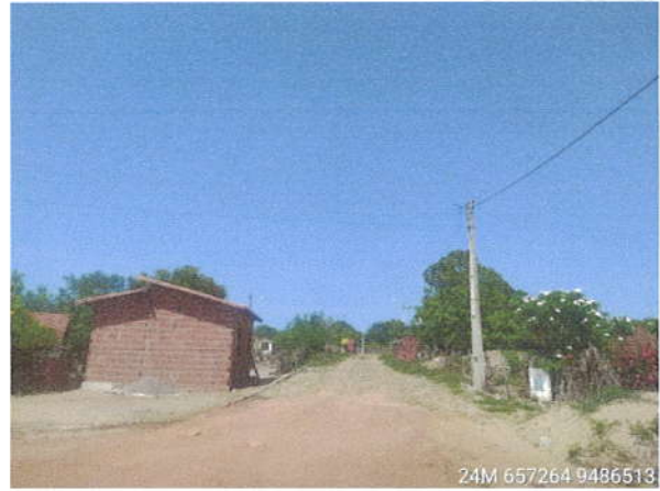
Parte do Calçamento existente em Estrada Picada da Areia - Corinos
