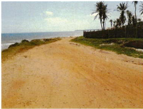
Foto 03 – Estrada a ser pavimentada, Retirinho.
