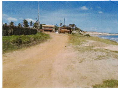
Foto 02 – Estrada a ser pavimentada, Retirinho.
