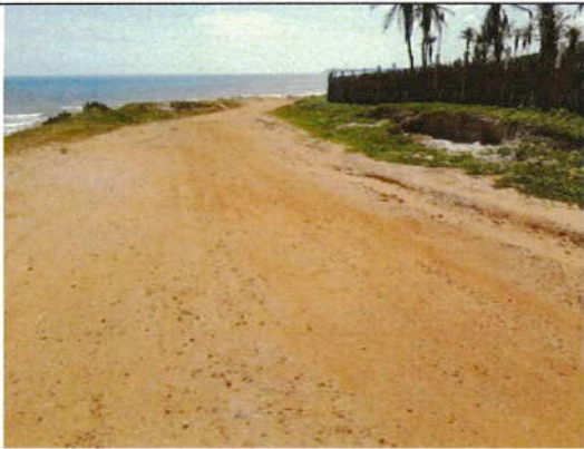
Foto 05 – Estrada a ser pavimentada, Retirinho.
