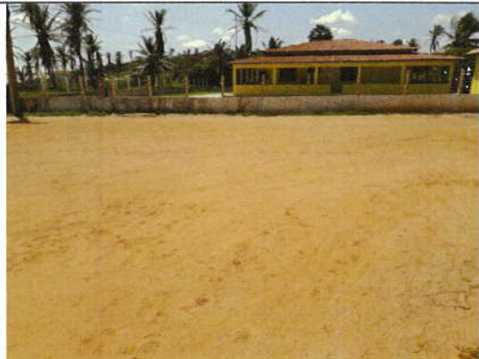
Foto 06 – Estrada a ser pavimentada, Retirinho.
