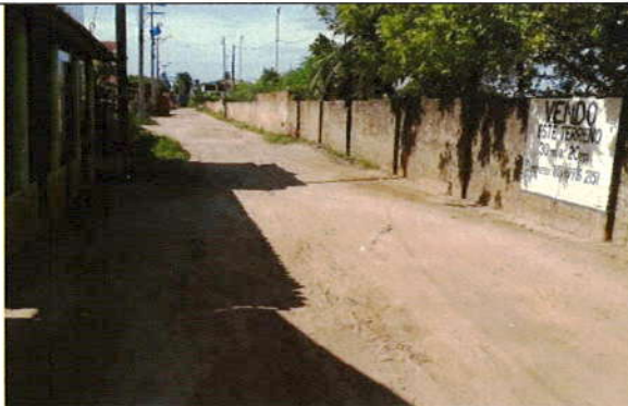
Foto 09 – Rua SDO 05 – Cumbe.
