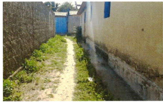
Foto 08 – Rua SDO 04 – Cumbe.
