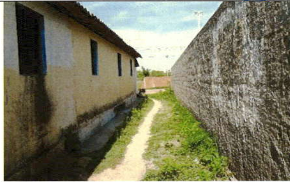
Foto 07 – Rua SDO 04 – Cumbe.
