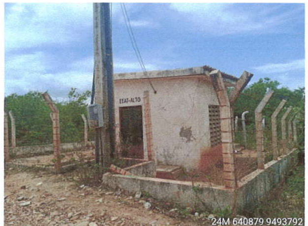
Vista da EEAT próxima ao Trecho
