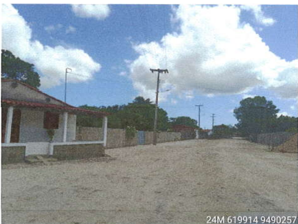
Visão geral da estrada
