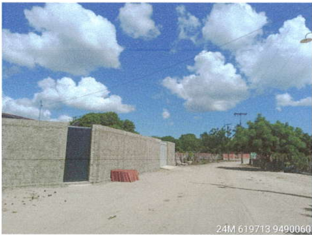
Visão geral da estrada
