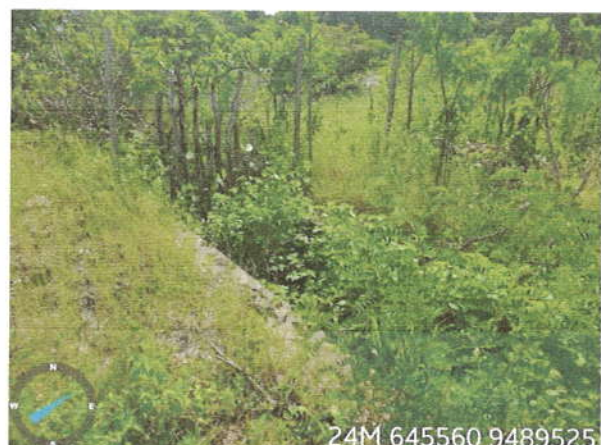
Visão do bueiro existente
