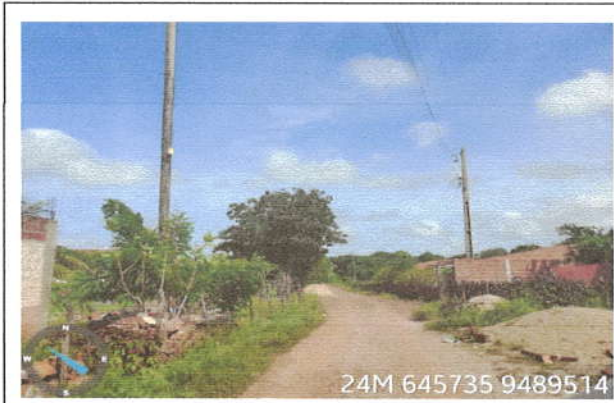
24M 645735 9489514 Visão geral da estrada de acesso a comunidade
