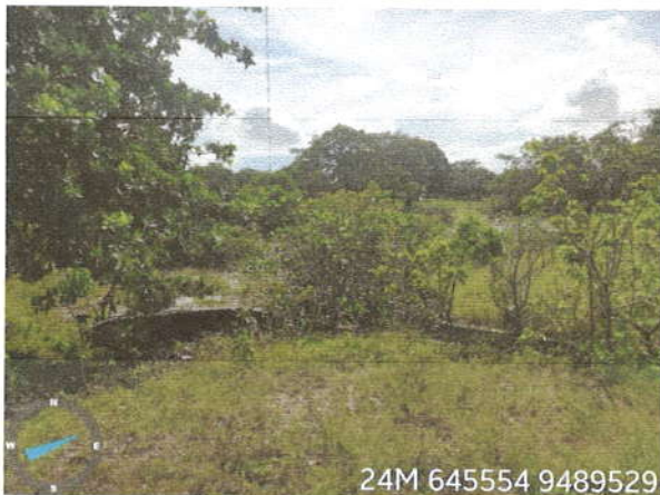
Visão do bueiro existente
