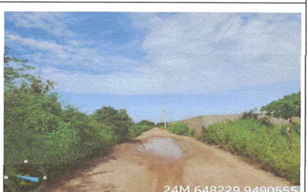
24M 648229 9490555 Visão geral da estrada em local de alagamento
