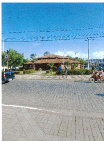
Foto 01: Fachada frontal do Centro de Artesanato, localizado à rua Visconde do Jaguaribe.
