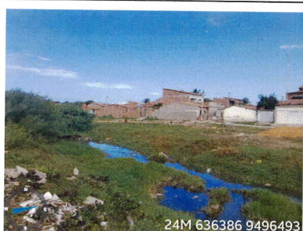
Vista do escoamento de água
