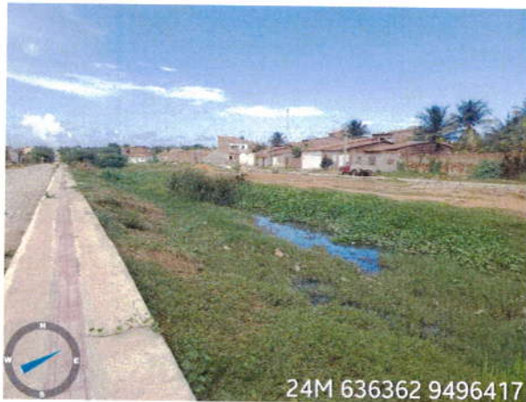
Vista do escoamento de água
