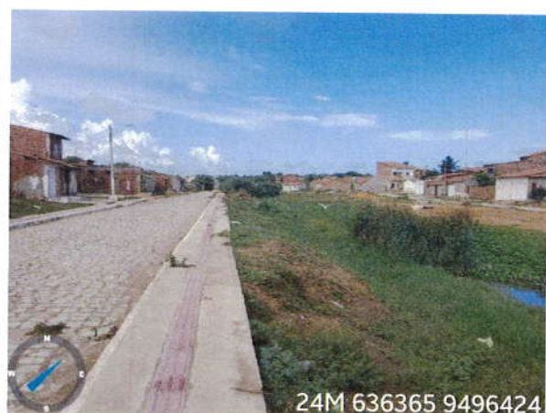
Vista do escoamento de água
