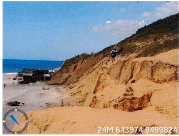
Vista da Falésia da Praça dos Pescadores
