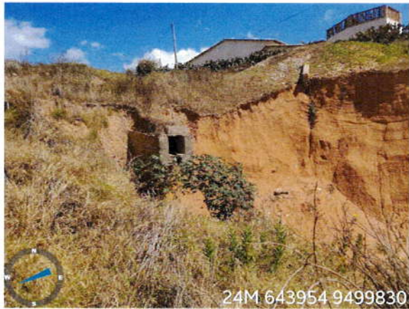
Vista da Boca do Bueiro
