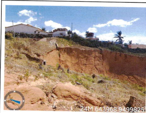
Vista da Falésia da Praça dos Pescadores
