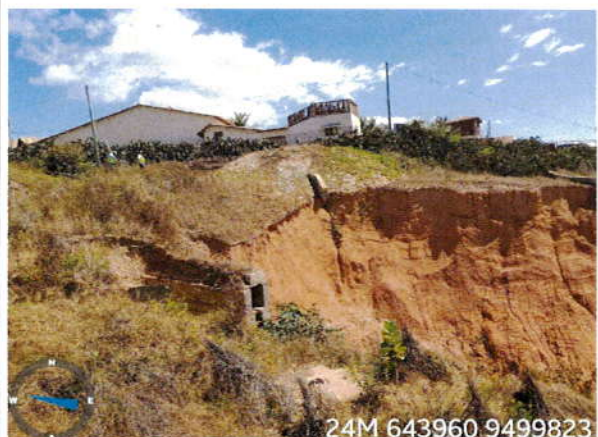
Vista da Falésia da Praça dos Pescadores
