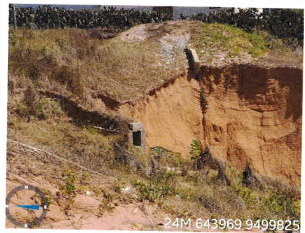
Vista da Falésia da Praça dos Pescadores
