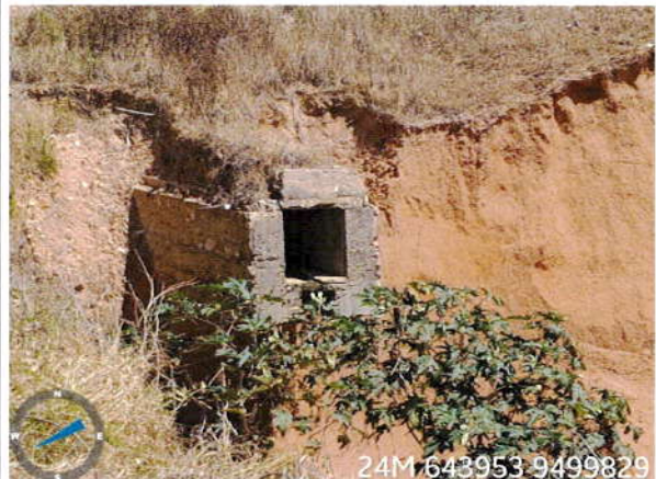
Vista da Boca do Bueiro
