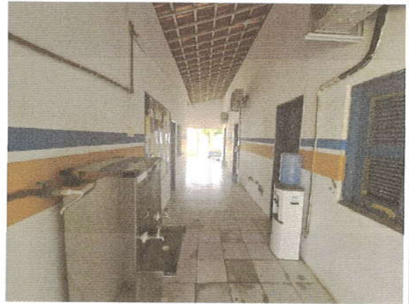
Vista do corredor da escola
