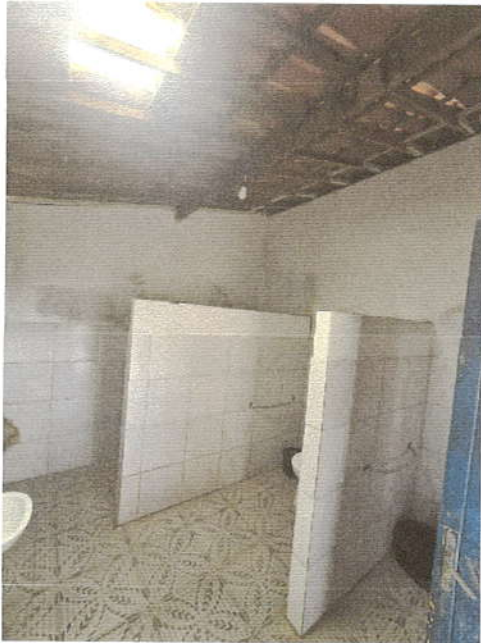
Vista interna do banheiro
