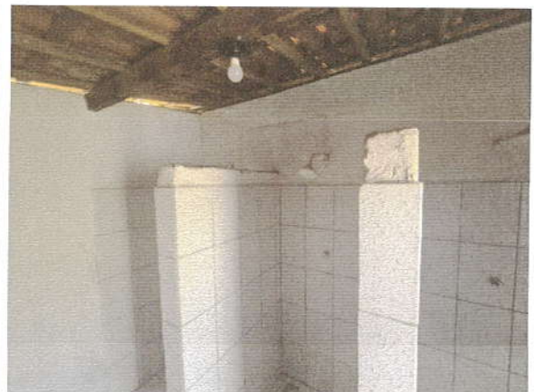
Vista interna do banheiro
