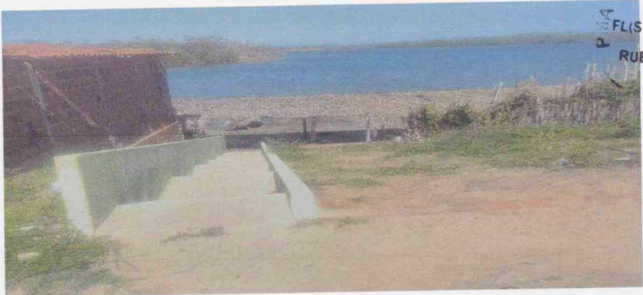
FIGURA 09 - EDIFICAÇÃO EXISTENTE ESCADA
