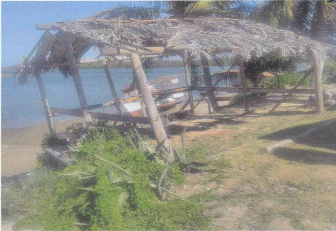
FIGURA 05 - RAMPA E ESCADA EXISTENTE
