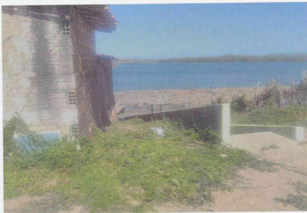
FIGURA 08 - EDIFICAÇÃO EXISTENTE: ESCADA
