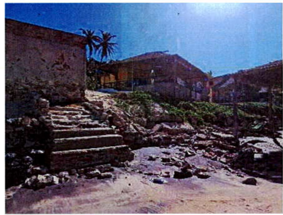
Vista da escada
