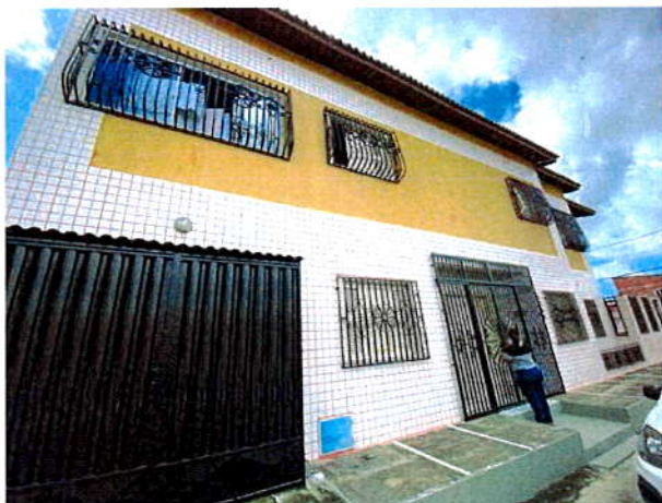
Fotografia 01 – Vista Frontal do Imóvel.
