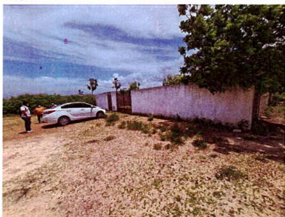
Vista da entrada da Escola
