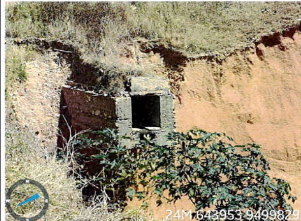
Vista da Boca do Bueiro
