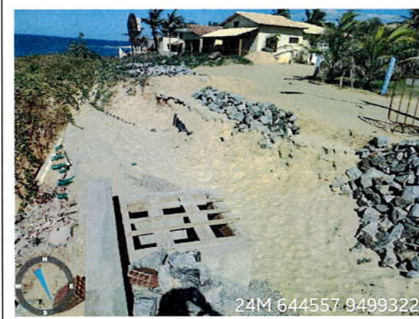
Vista da Caixa de captação existente
