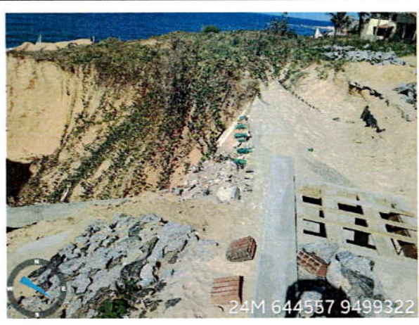
Vista da Caixa de captação existente
