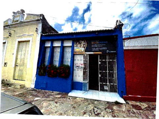
Fotografia 01 – Vista Frontal do Imóvel.
