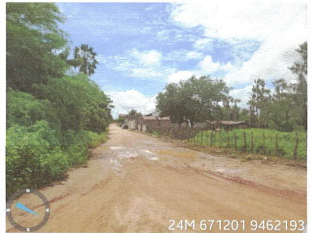
Rua SDO 13 - Local da Passagem Molhada Projetada
