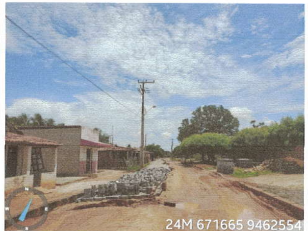
Rua SDO 07 - Área em obras de pavimentação
