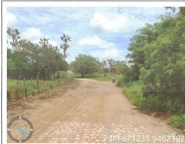
Rua SDO 13 - Próximo à passagem molhada projetada
