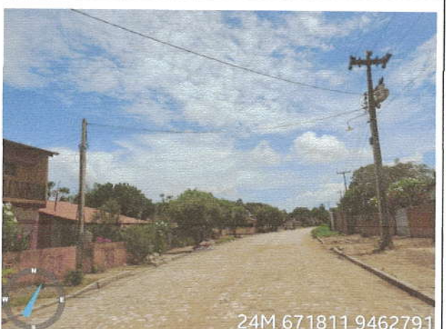
Rua SDO 07 - Área pavimentada
