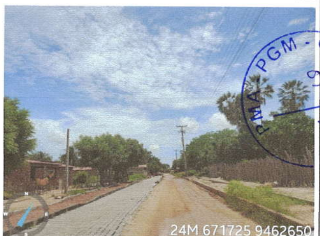
Rua SDO 07 - Área em obras de pavimentação
