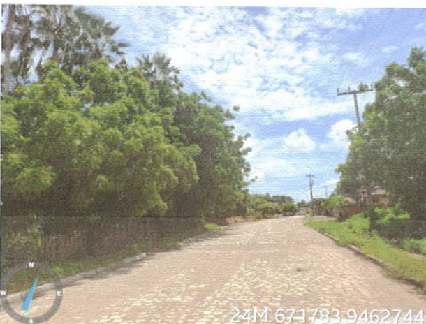
Rua SDO 07 - Área pavimentada
