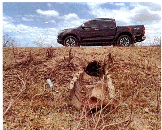
Foto 04 – Bueiro existente \varnothing = 0,60 .
