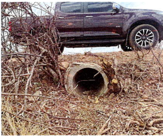
Foto 03 – Bueiro existente \varnothing = 0,60 .
