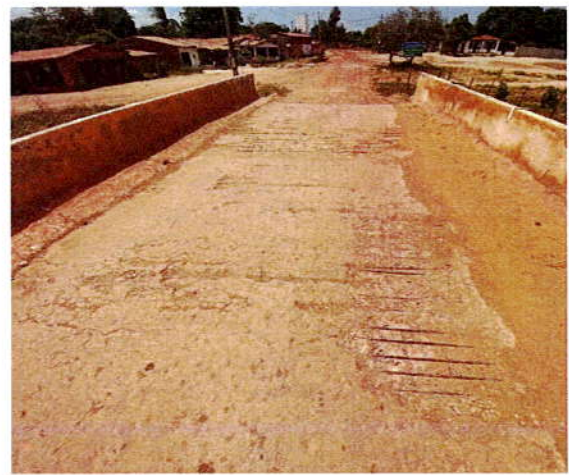
Foto 06 – Laje da ponte existente.
