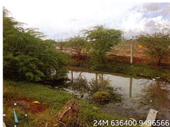
Vista do Fim da Galeria de Concreto
