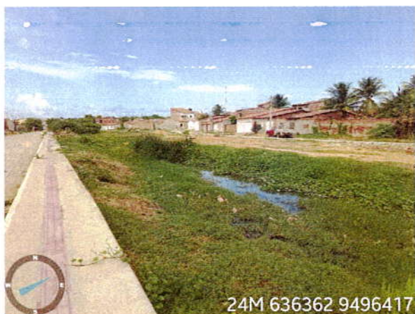
Vista do escoamento de água
