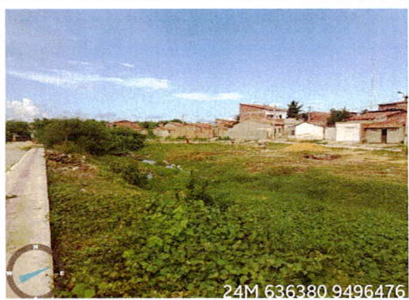
Vista do escoamento de água
