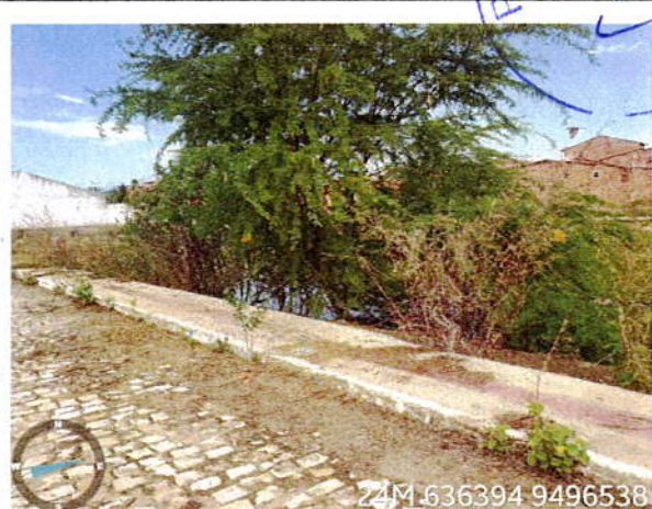
Vista do escoamento de água
