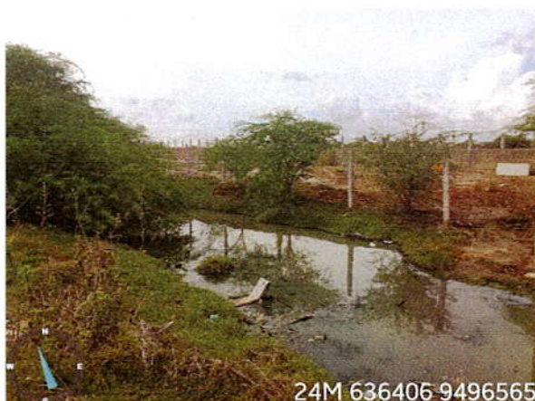
Vista do escoamento de água
