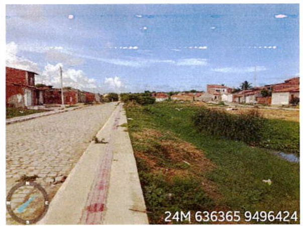
Vista do escoamento de água
