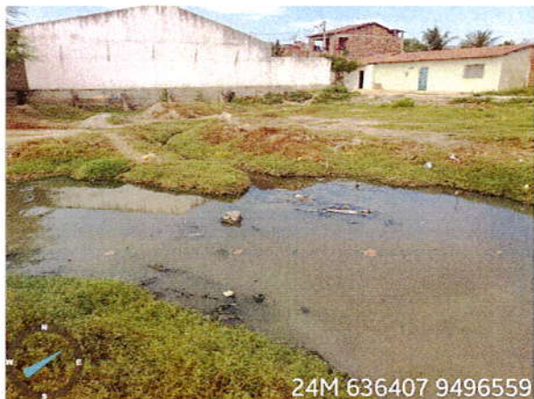
Vista do escoamento de água
