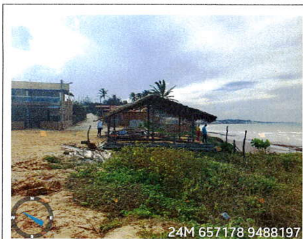
Local de construção do platô
