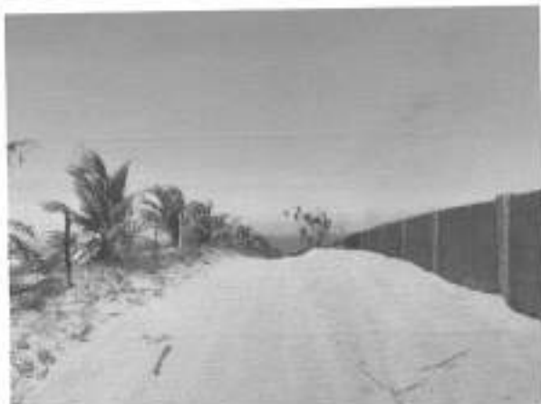
Vista do Trecho 05
