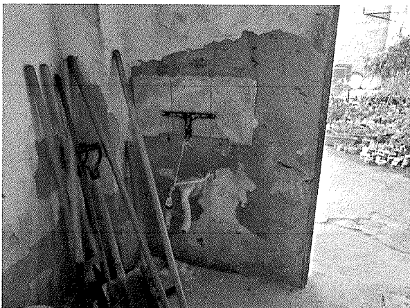
Vista interna da edificação - 03
