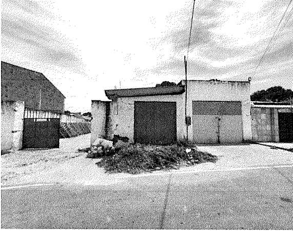
Vista frontal da edificação
