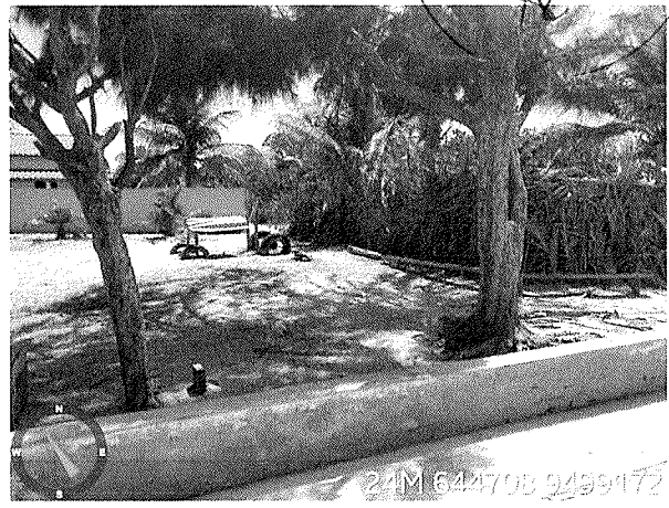
Visão Geral - mureta em torno da quadra
