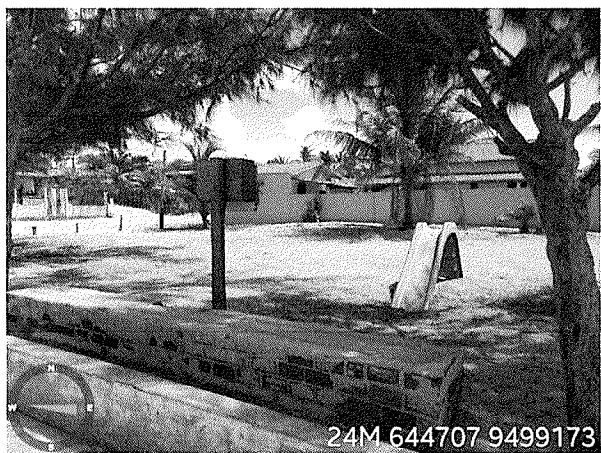
Visão Geral - banco de alvenaria
