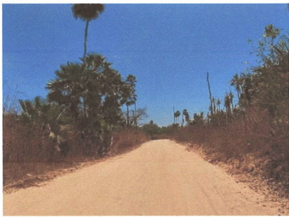
Visão geral da via
