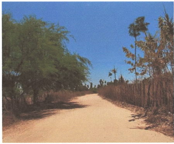
Visão geral da via
