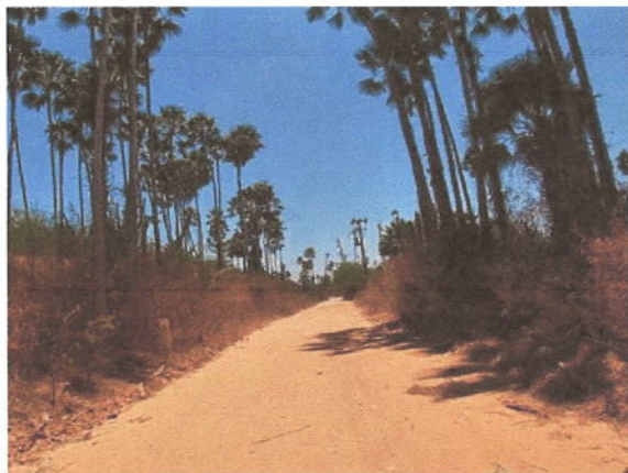
Visão geral da via
