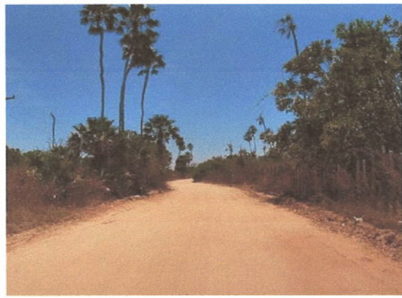
Visão geral da via
