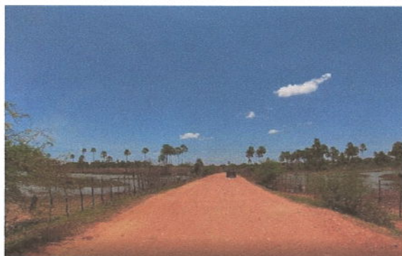
Visão geral da via
