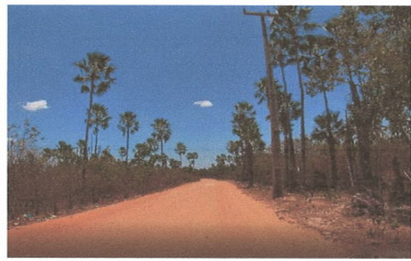
Visão geral da via
