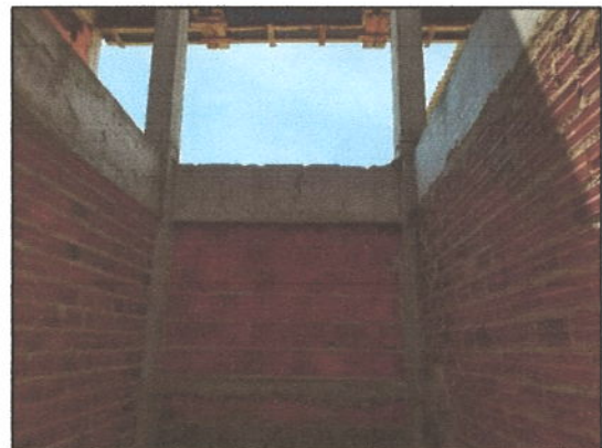
Imagem 12 – Poço do elevador
