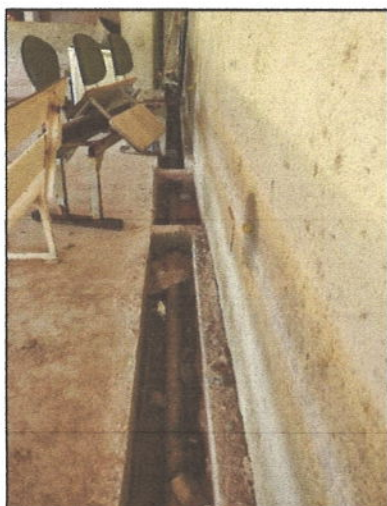
Imagem 7 – Detalhe tubulação hidrossanitária existente
