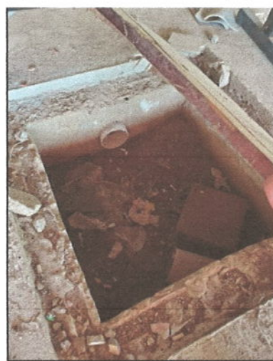
Imagem 8 – Detalhe caixa de inspeção existente
