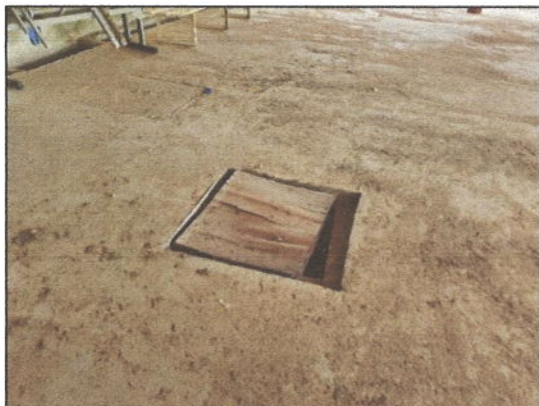
Imagem 11 – Caixa de esgoto existente
