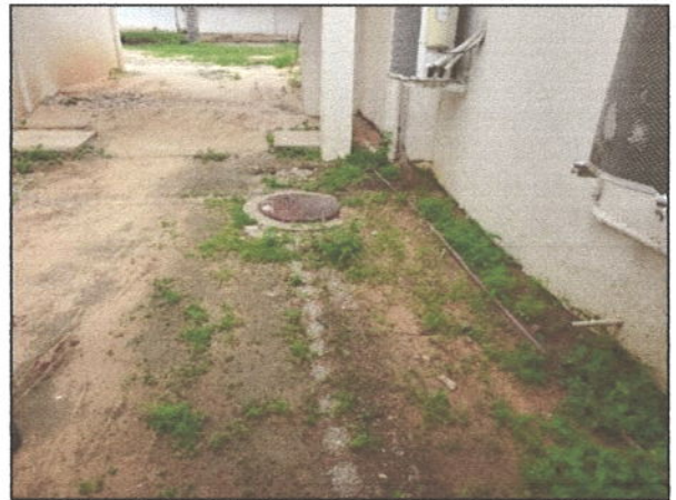
Imagem 10 – Poço de visita
