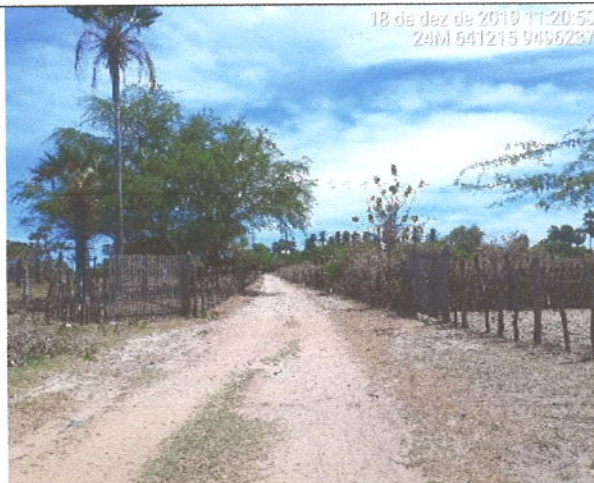
Visão Geral da via Estaca 2+940
