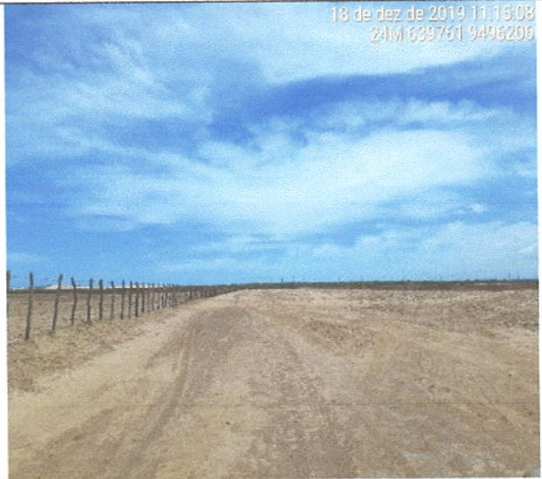
Visão Geral da via Estaca 1+540
