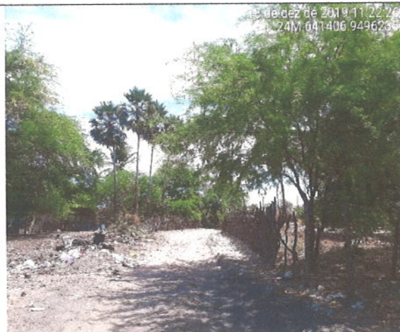
Visão Geral da via Estaca 3+180
