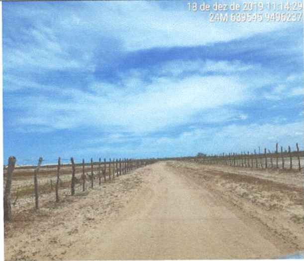
Visão Geral da via Estaca 1+320
