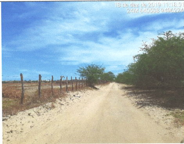
Visão Geral da via Estaca 2+120
