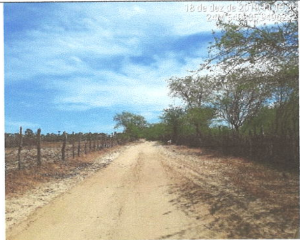
Visão Geral da via Estaca 2+660
