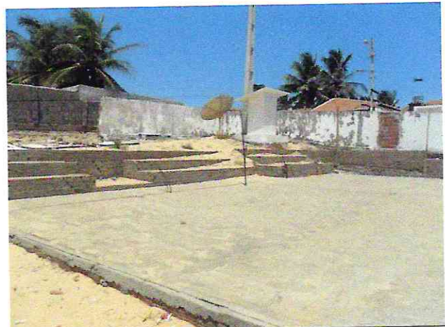
Quadra Poliesportiva e arquibancadas inacabados
