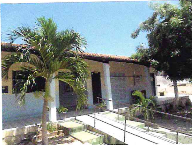
Rampa de acesso
