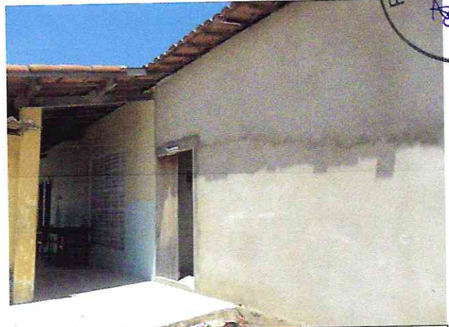
Sala inacabada sem acesso coberto
