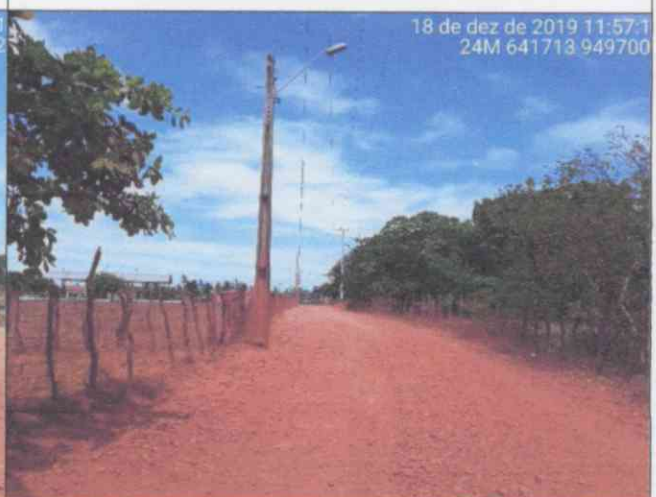
Visão Geral da via – Estaca 0+800,00
