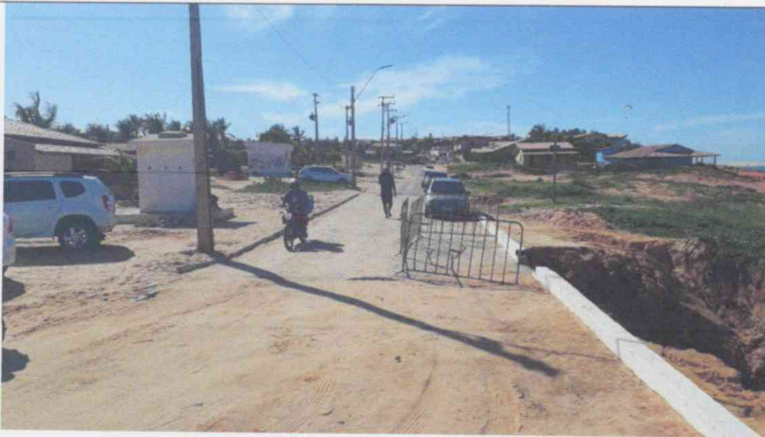
Chegada no Local da Drenagem – Chegada na Rua Estevão Cinco
