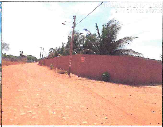
Visão Geral da via – Estaca 1+170,00
