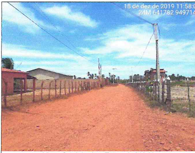
Visão Geral da via – Estaca 0+940,00
