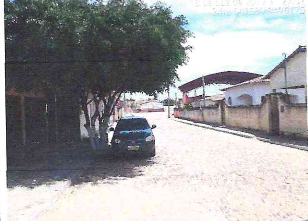
Trecho 04 – Córrego dos Rodrigues (Estaca 0+190,00)
