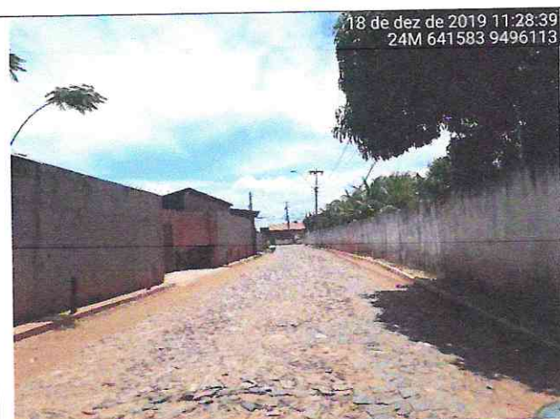
Trecho 05 – Córrego dos Rodrigues (Estaca 0+70,00)
