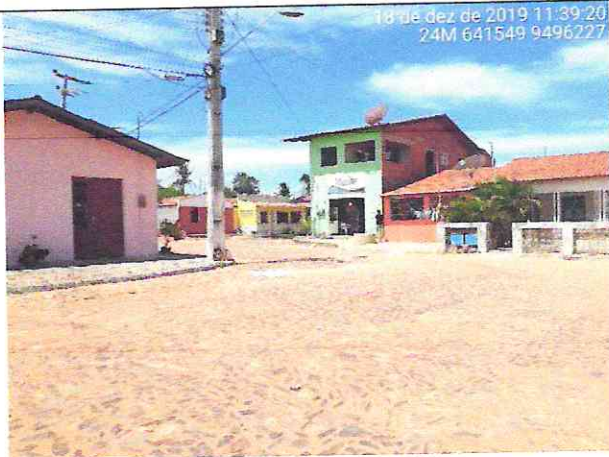
Trecho 03 – Córrego dos Rodrigues (Estaca 0+40,00)
