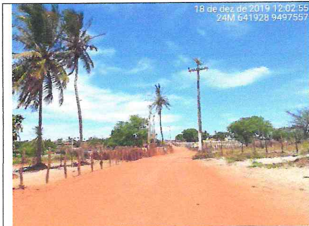
Trecho 01 – Córrego da Nica (Estaca 0+130,00)
