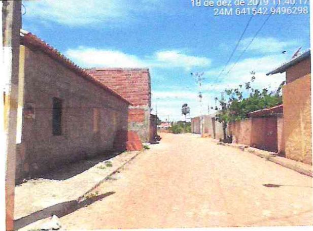
Trecho 02 – Córrego dos Rodrigues (Estaca 0+60,00)
