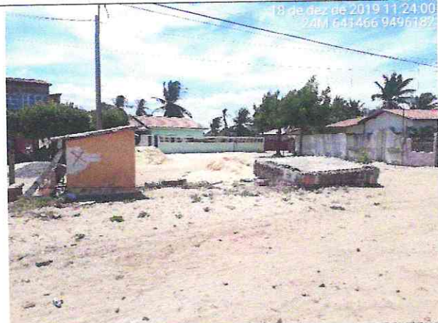
Trecho 04 – Córrego dos Rodrigues (Estaca 0+60,00) com visão para trecho 06
