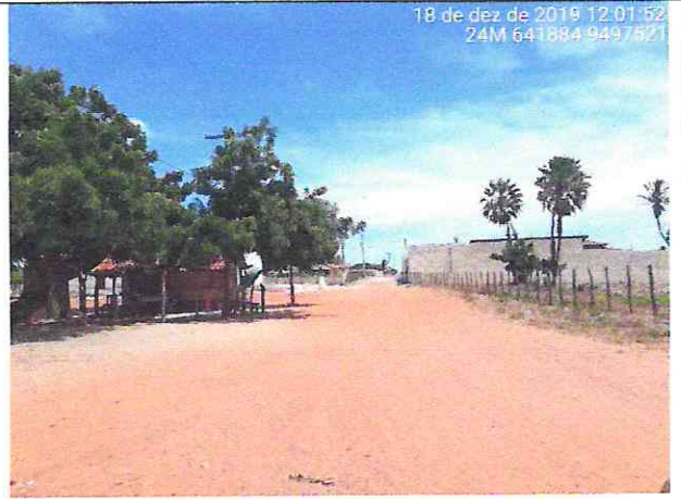
Trecho 02 – Córrego da Nica (Estaca 0+5,00)
