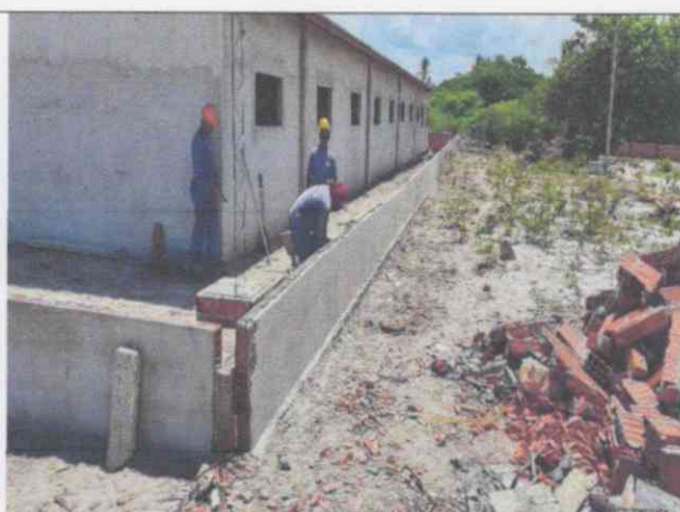
Escola em construção
