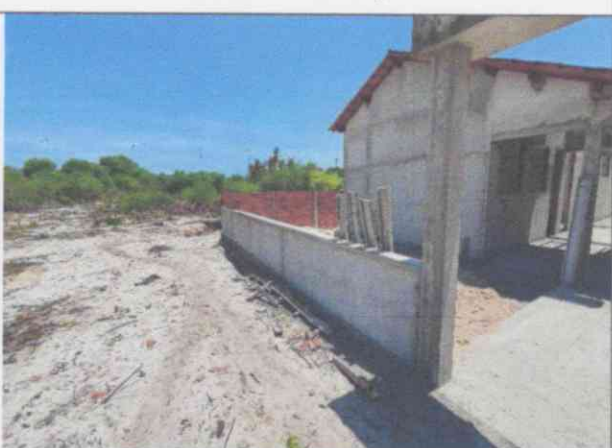
Escola em construção
