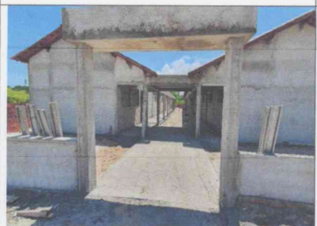
Escola em construção
