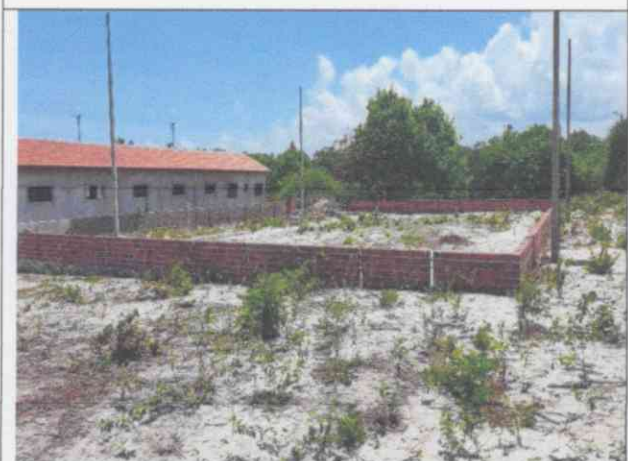
Escola em construção
