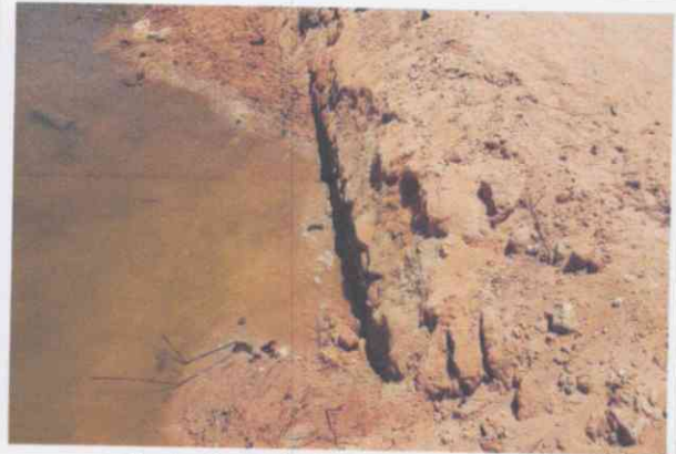
Bueiro Capeado de Concreto Aterrado
