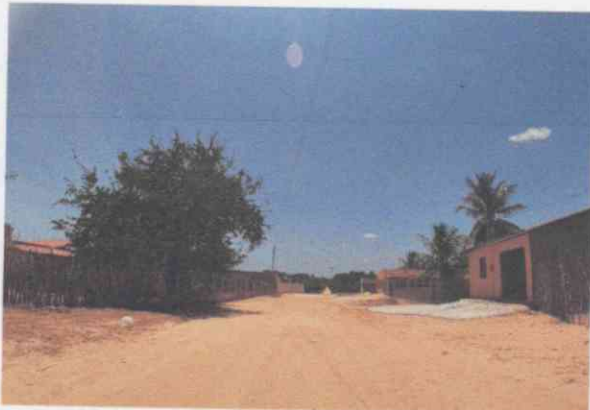
Visão geral da via
