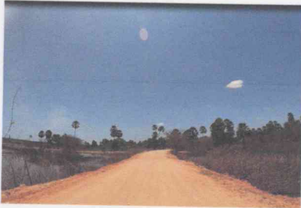
Visão geral da via
