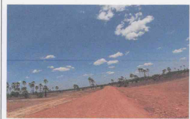
Visão geral da via
