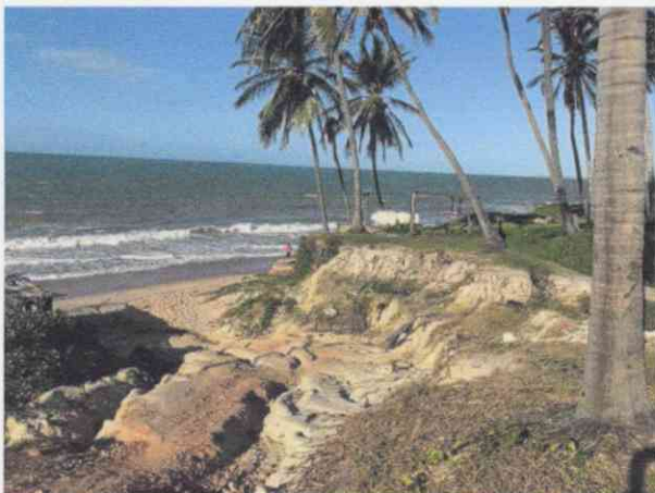
Observações: Áreas com erosão.
