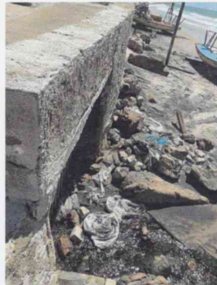
Observações: Bueiro existente.
