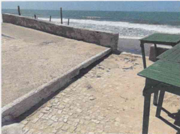
Observações: Boca de lobo existente.
