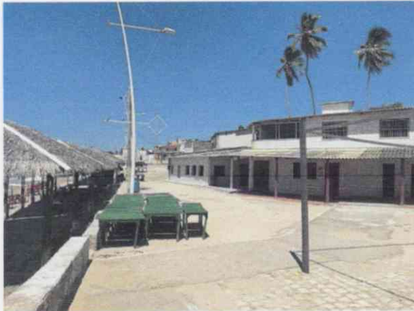
Observações: Mureta existente no limite do calçadão.
