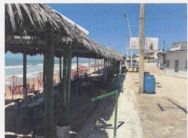
Observações: Escada em concreto e guarda corpo metálico existentes.
