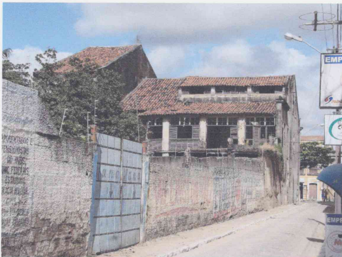
Fig. 03: Fachada posterior da edificação vista a partir da Tv. Barão de Messejana.
