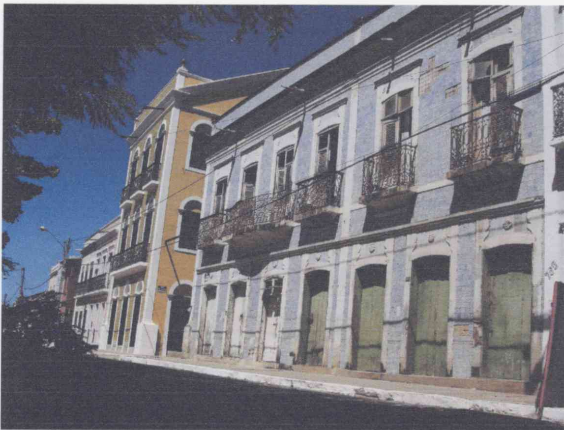
Fig. 02: Fachada principal da do sobrado com edifício do museu Jaguaribano ao fundo.
